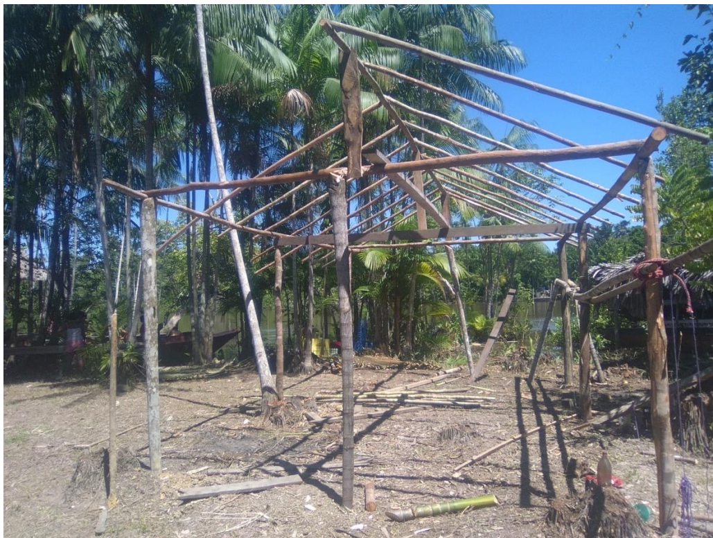
Figura 38 – Barracão ganhando forma. Fonte: Trabalho de campo, 2017.
