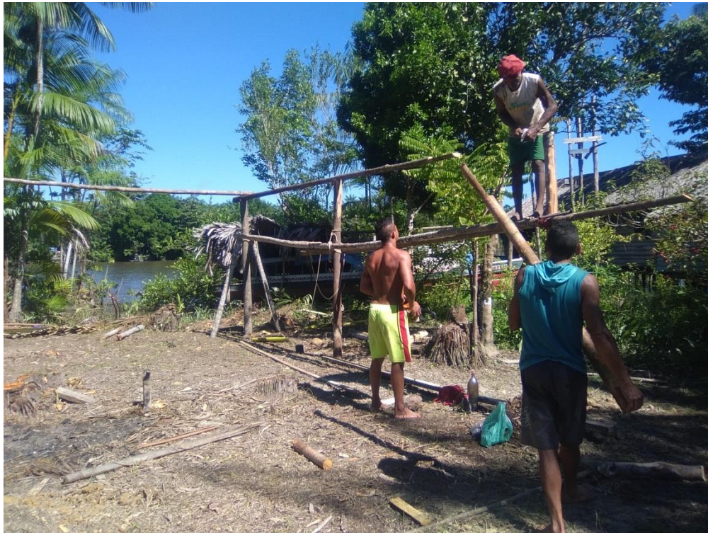
Figura 36 – Seu Ivan e seu filho mais velho (sem camisa) junto com um amigo da comunidade (irmão do Seu Ivan), iniciando a construção do barracão. Fonte: Trabalho de campo, 2017.
